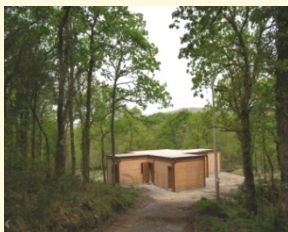
Edifício Multiusos "Os Prados"
