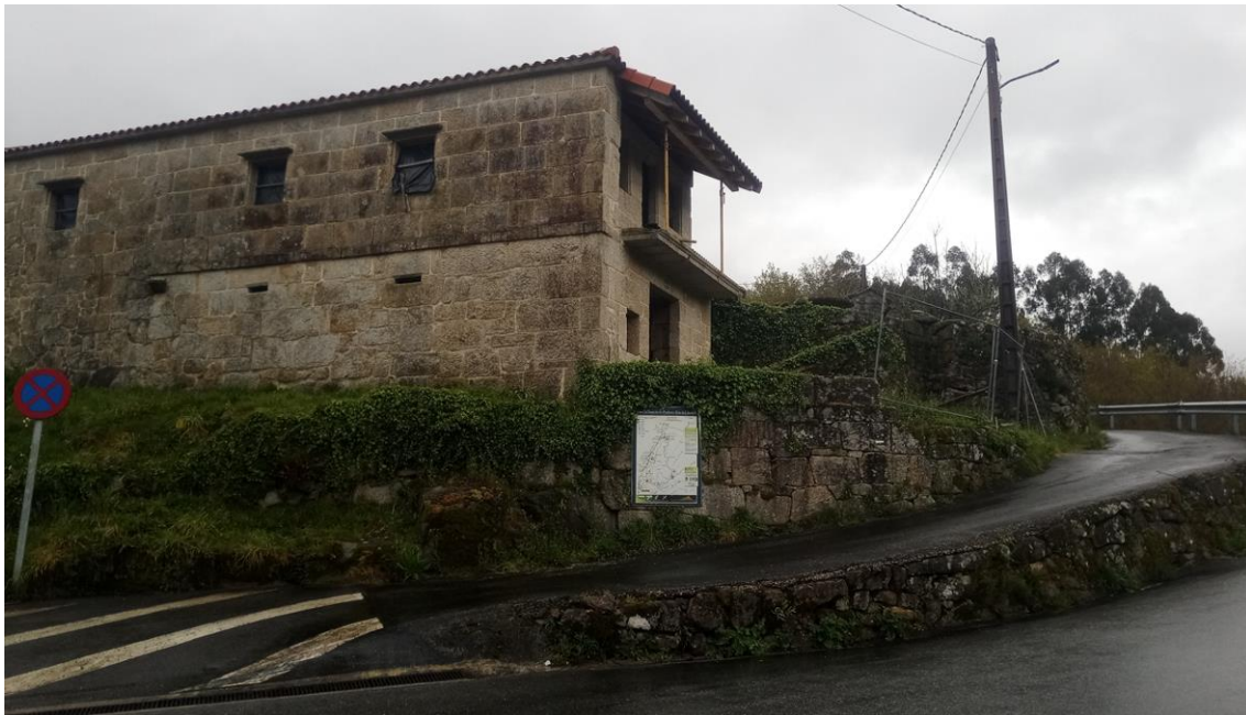
Camiño principal de acceso ás fincas no punto de conexión ca EP-3060.
